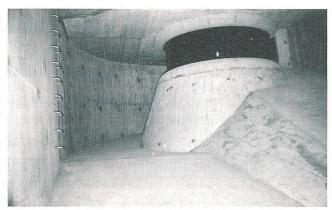
Die Einlaufspirale verteilt die Druck- und Geschwindigkeitsenergie gleichmässig auf die fixe Stützschaufel.
