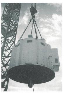
Die Generatoren erreichen bessere Wirkungsgrade als Schnellläufer und Getriebe zusammen.
