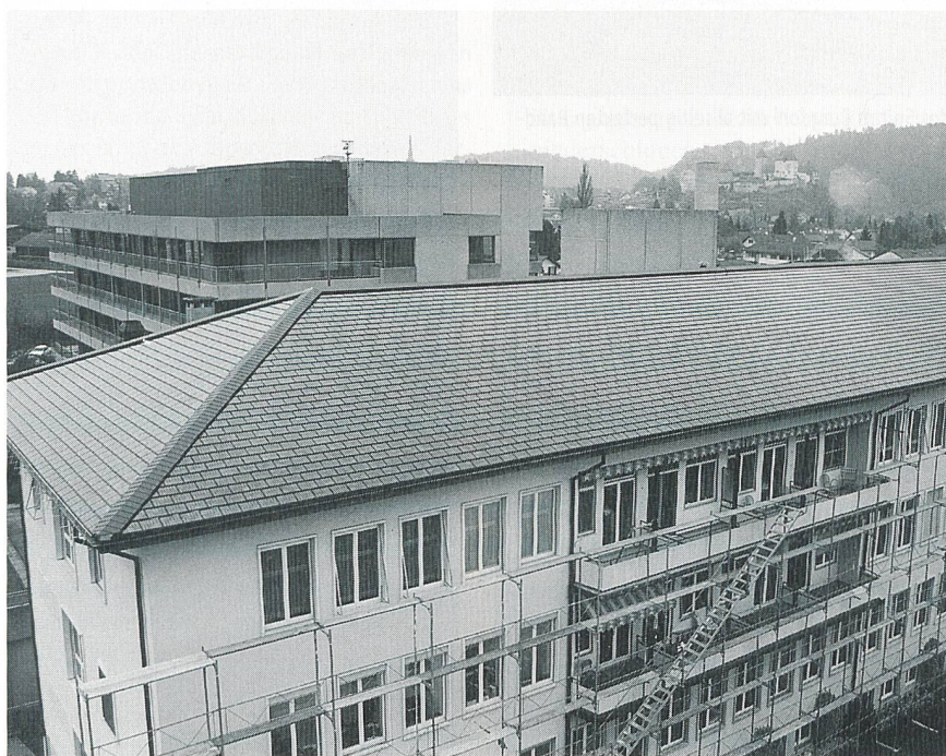
Bild 1 Neu eingedecktes Solarschieferdach des Regionalspitals Burgdorf.
