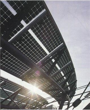
Der 100 kW<sub>P</sub>-Solargenerator des Solgården-Projekts in Kolding DK
