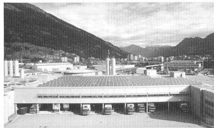
1332 m 2 Modulfläche auf dem Dach der Coop-Verteilzentrale.
