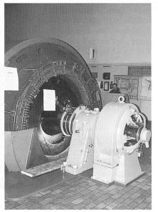
13-MVA-Generator mit zugehöriger Erregermaschine im Fätschbachwerk.
