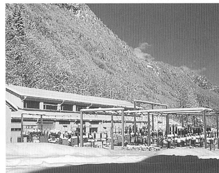
Gesamtüberblick Fätschbachwerk mit 50-kV-Schaltanlagen.
