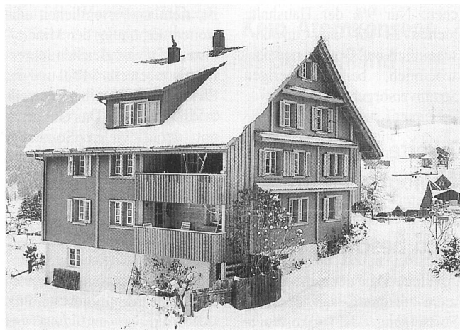
Saniertes Gebäude in der Gemeinde Oberiberg: erfolgreichste Schweizer Gemeinde im Investitionsprogramm «Energie 2000».
