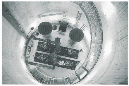
Bild 4 Blick in den Schützenschacht (Fliessrichtung des Wassers von «unten» nach «oben»). Zu erkennen sind: Die Kastendeckel und die Antriebe der hintereinanderliegenden Schützen mit ihren Schlackenschleusen, die beiden Belüftungsrohre und dazwischen der quadratische Einstieg in den unterwasserseitigen Stollen. Der Schacht ist durch die ebenfalls sichtbare Wendeltreppe erschlossen.
