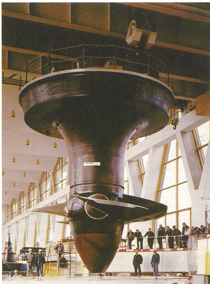
Bild 4 Modernisierung der Kaplanturbinen im Rheinkraftwerk Birsfelden (CH).
