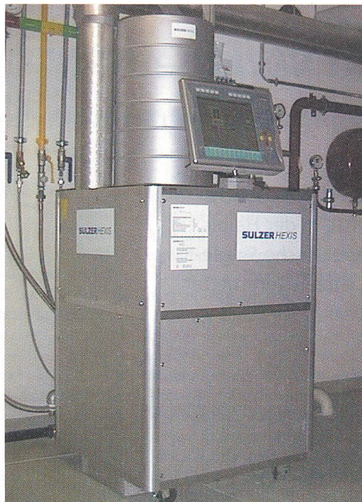
Brennstoffzellen-System (1 kW el) Betreiber: AET Basel (Amt für Energie und Technik), seit 1998
