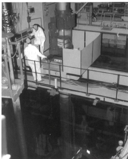
Untersuchung des Reaktordruckgefässes mit Ultraschall.
