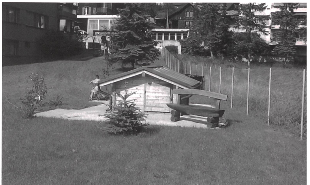
Bild 1 Heutiger Zustand des Bohrlochkopfes, als Chalet getarnt.
