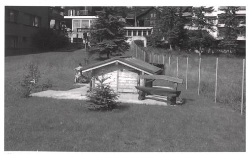
Bild 1 Heutiger Zustand des Bohrlochkopfes, als Châlet getarnt.
