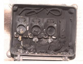
Bild 9 Verkohlter Anschlusssicherungskasten
