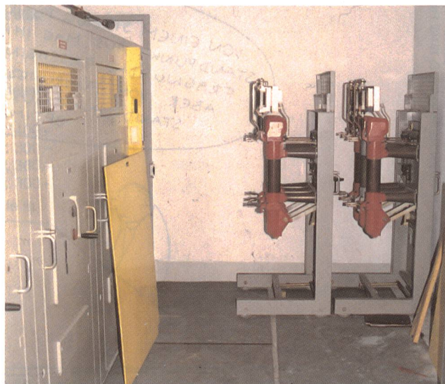
Bild 13 In den Fluchtweg geschobener Schalterwagen
