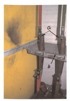
Bild 12 Schalterkontakte, an denen ein Erdschluss erzeugt wurde
