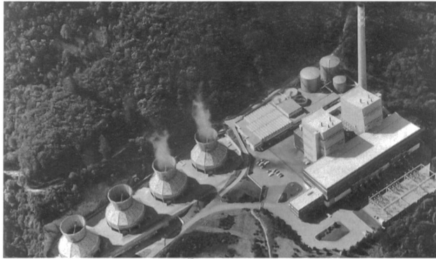
La centrale de Chavalon: les installations de production vont donc être démontées.
