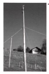
→ Das Besteigen von Holzmasten ist ohne entsprechende Sicherung verboten! Ein Holzmast ist gesichert durch beidseits festverbundene Leitung mit mindestens 8 mm Ø, gesichert durch Hebebühne oder durch geeignete Abstützung im oberen Drittel des Mastes.
