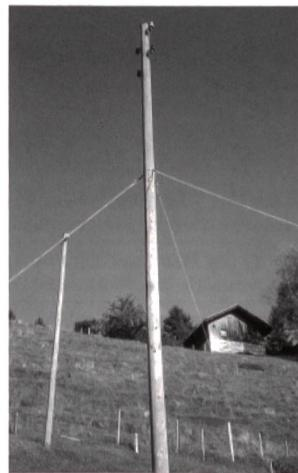
→ Das Besteigen von Holzmasten ist ohne entsprechende Sicherung verboten! Ein Holzman ist gesichert durch beidseits festverbundene Leitung mit mindestens 8 mm Ø, gesichert durch Hebebühne oder durch geeignete Abstützung im oberen Drittel des Mastes.
