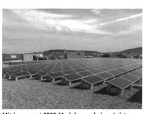
Mit insgesamt 2392 Modulen und einer Leistung von 270 kW<sub>p</sub> ist die Solarstromanlage «Pluto» der Zürcher Freilager AG die grösste Solaranlage der Schweiz auf überbauter Fläche. Auch sie speist in die Zürcher Solarstrombörse ein.
