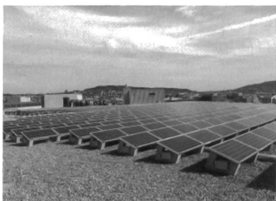
Mit insgesamt 2392 Modulen und einer Leistung von 270 kW p ist die Solarstromanlage «Pluto» der Zürcher Freilager AG die grösste Solaranlage der Schweiz auf überbauter Fläche. Auch sie speist in die Zürcher Solarstrombörse ein.
