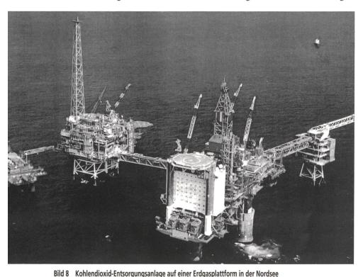
Die mittlere Plattform beherbergt die Apparaturen zur Abtrennung, Kompression und Verflüssigung des Kohlendioxids. (Quelle: Statoil)
