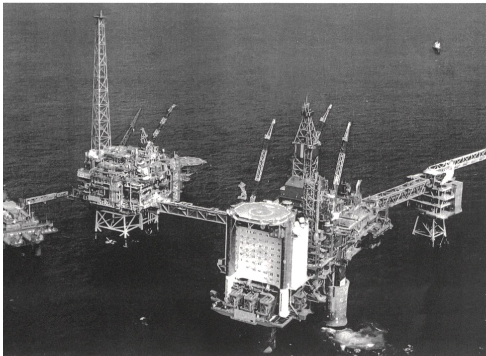
Bild 8 Kohlendioxid-Entsorgungsanlage auf einer Erdgasplattform in der Nordsee
