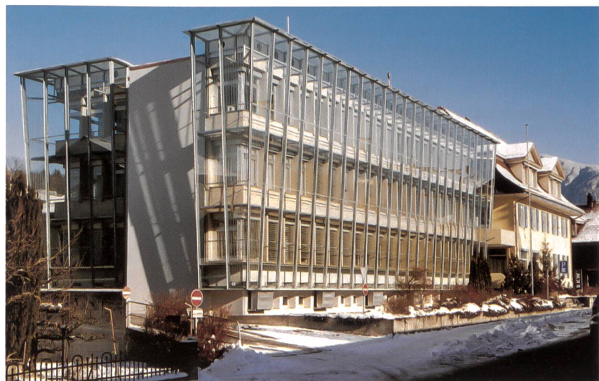
Bild 1 Gesamtansicht des Verwaltungsgebäudes der BKW FMB Energie AG in Spiez
