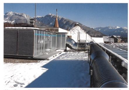
Bild 2 Lüftungsmonobloc / Wärmepumpe / Wärmerückgewinnung mit Luftansaugkanälen aus den Pufferzonen
