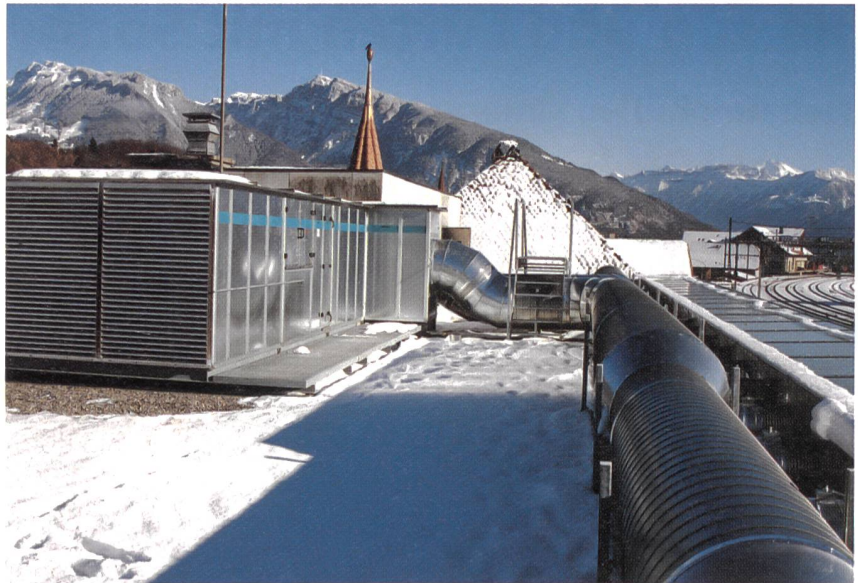
Bild 2 Lüftungsmonoblock / Wärmepumpe / Wärmerückgewinnung mit Luftansaugkanälen aus den Pufferzonen
