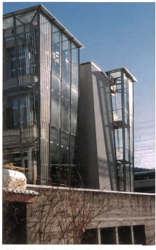
Bild 3 Eckdetails der Glasfassade mit Vogelschutzstreifen
