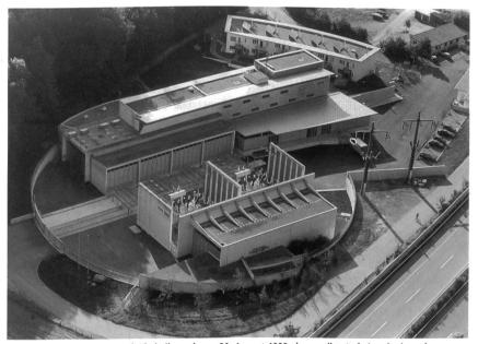
Das neue EKZ/NOK-Unterwerk Thalwil wurde am 20. August 1999 eingeweiht. Auf einer kreisrunden Betonplatte von 77 Metern Durchmesser sind gegen die Autobahn A3 hin die beiden je über 180 Tonnen schweren Reguliertransformatoren der NOK und die zugehörige 220-kV-Innenraumschaltanlage plaziert.
