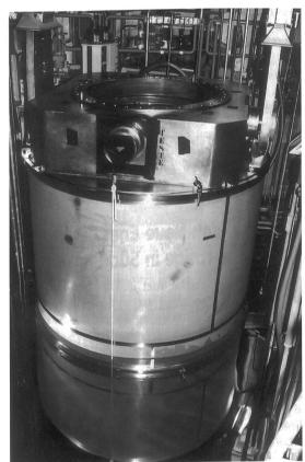
Der Transportbehälter wird in das Beladebecken abgesenkt.
