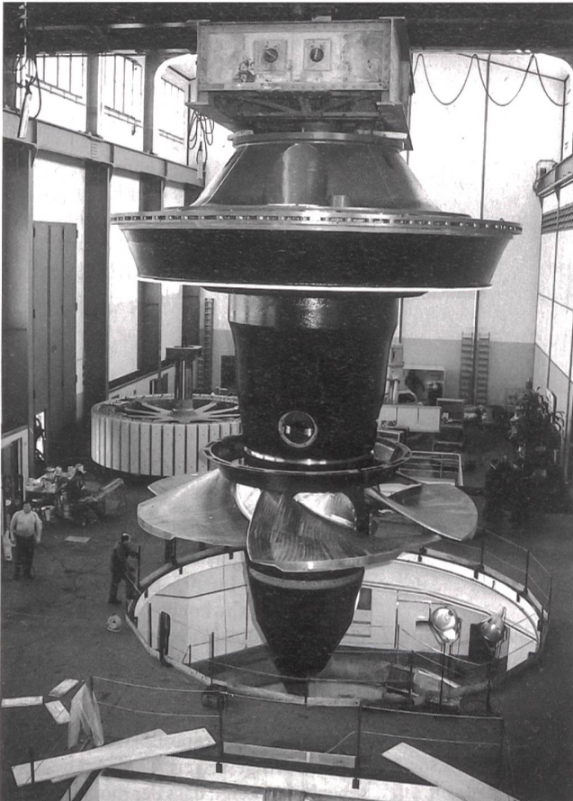
Ausbau der Wasserkraft: das Ziel «plus 5%» dürfte zu rund drei Vierteln erfüllt werden (Kaplanturbine, Bild NOK).
