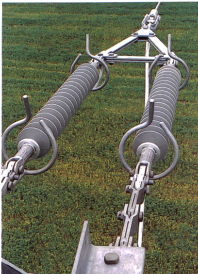
Erlauben leichte, kostengünstigere Mastkonstruktionen: SIMOTEC-Verbundisolatoren, hier für eine 110 kV-Freileitung.
