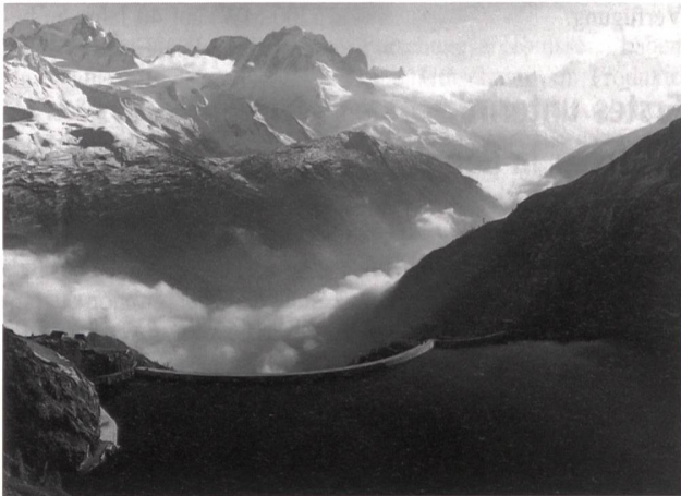
Staumauer Emosson: Messprogramm abgeschlossen.
