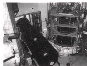
Im belgischen Kernkraftwerk Doel 4 wurden kürzlich die drei Dampferzeuger ausgetauscht.
