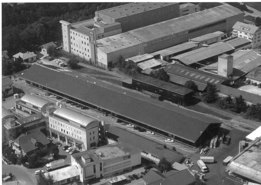
Weltgrösstes Solarziegeldach (Bildmitte: 2000 m 2 Sunslates) des eidgenössischen Getreidemagazins in Bern (Nennleistung 200 kW, Bild EWB).
