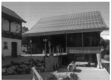
24-kW-Solarzellenanlage auf einem Scheunendach in Maur ZH (Bild EKZ).
