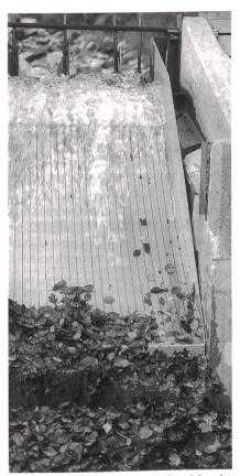
Bild 6 Laubanfall: der Rechen ist selbstreinigend.
