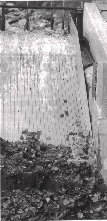
Bild 6 Laubanfall: der Rechen ist selbstreinigend.
