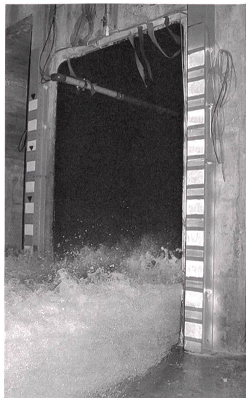
Bild 1 Gemischabfluss am Ende des Grundablassstollens Panix. Im Deckenbereich strömt Luft in den Grundablassstollen entgegen der Fliessrichtung des Gemischabflusses.
