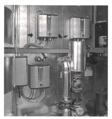
Bild 1 ACM-Module, platzsparend, sicher und kostengünstig (Foto ABB)
