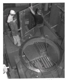
Der Plasma-Ofen wird montiert. Sein Lichtbogen kann neben brennbaren auch unbrennbare radioaktive Abfälle zersetzen und aufschmelzen.
