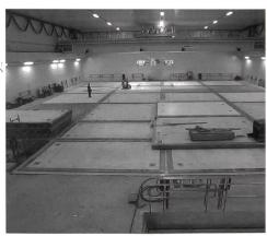
In dieser Lagerhalle werden Abfallgebinde mit mittelaktiven Abfällen zwischengelagert. Die Lagerschächte werden mit Betonplatten verschlossen. Fotos: Zwilag
