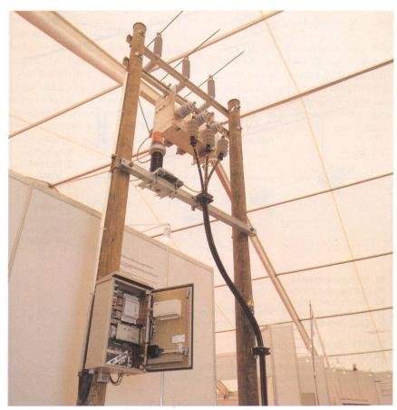
Bild 7 Mit DLC ferngesteuerter Mastschalter.
