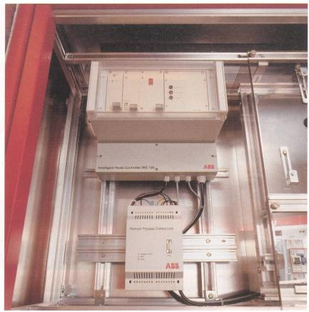
Bild 6 INC 120 als Datenkonzentrator in einer Unterstation (1) mit MS- und NS-DLC-Kommunikation und angeschlossener Fernwirkeinheit (RTU) (2) .
