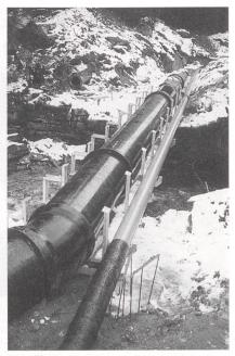
Bild 6 Wie hier bei der ungedeckten Rohrbrücke sichtbar, wurde neben der Kraftwerksdruckleitung noch eine Hochdruckleitung für die Beschneiungsanlage verlegt.
