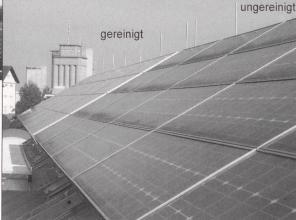
Bild 2 Ansicht eines Teils des Solargenerators der 60-kW<sub>p</sub>-PV-Testanlage der HTA Burgdorf: Die Module auf der linken Seite sind frisch gereinigt. Bei den Modulen auf der rechten Seite ist die Verschmutzung am unteren Modulrand sichtbar, die sich in der Zeit von Juni 1993 bis Mai 1998 angesammelt hat.
