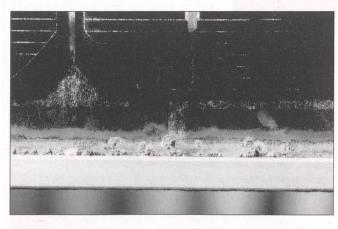
Bild 6 Detailansicht des Moduls von Bild 5 von einer Stelle, wo sich bereits Flechten entwickeln.
