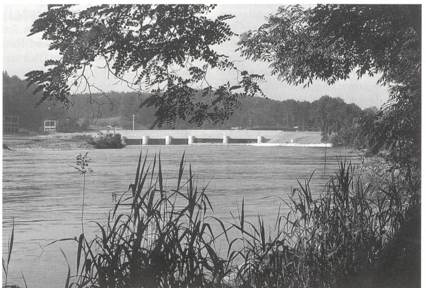
Das Wasserkraftwerk Bannwil der BKW (Bild) wird zusammen mit den Wasserkraftwerken Gösgen, Ruppoldingen und Flumenthal der operativen Führung der Atel unterstellt.
