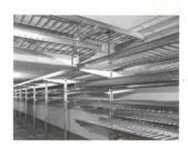
Kabelführungen aus rostfreiem V 4 A-Stahl
