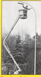
Korrosionsschutz an Stahlkandelabern
