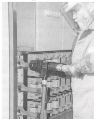
Flachschienenabgriff bis 450 A
