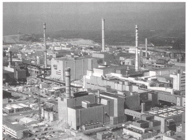
Wiederaufarbeitungsanlage abgebrannter Brennelemente «La Hague». Auf dem 300 Hektar grossen Werksgelände in der Normandie arbeiten 5000 Menschen. Jährlich können bis zu 1700 Tonnen abgebrannte Brennstäbe rezykliert werden.
