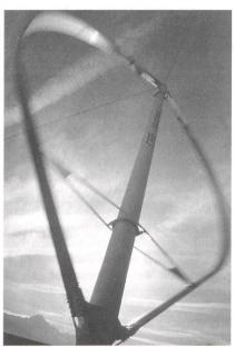
Bild 4 Darrieus-Windturbine aus Aluminium.
