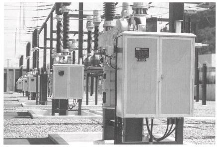
Bild 2 Aluminium-Steuerschränke zu Hochspannungsschalter.
