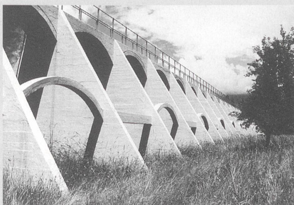
Staumauern: Ein schönes Beispiel ist die vor rund 75 Jahren erbaute, mit ihrer Leichtigkeit fast verspielt wirkende Mehrfach-Bogenstaumauer des Ausgleichsbeckens der SBB-Kraftwerke Châteland-Barberine-Verneyaz bei Les Marécottes (VS). (Foto: Emmanuel Rey)
