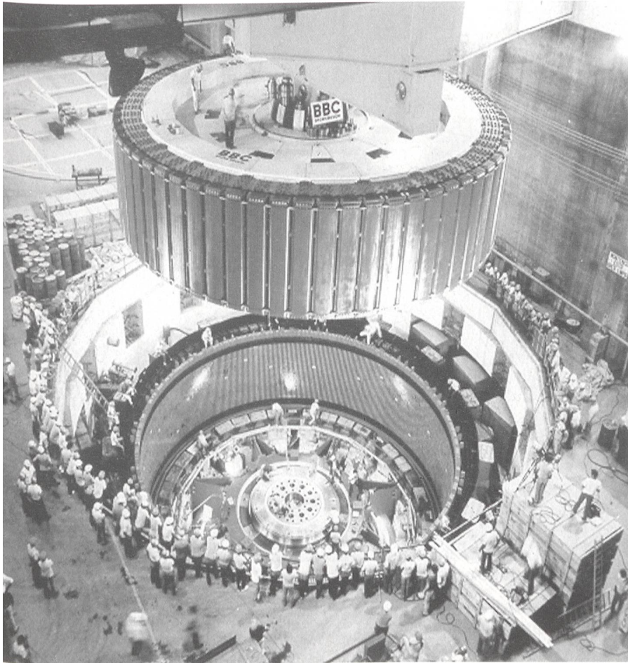
Bild 6 Generator-Rotor wie er für das «Drei-Schluchten-Projekt» vorgesehen ist (hier für das Wasserkraftwerk Itaipú).
