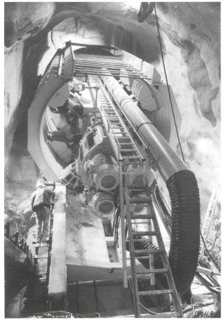
Bild 6 Startröhre für die Druckschachtfräse. Der Schacht ist 382 m lang und hat 85% Gefälle (Photo P. Mainardi).
