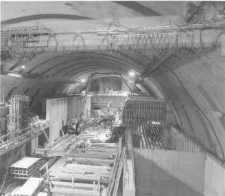
Bild 1 Eindrückliche Ausmasse: Die Kavernenzentrale Amsteg während des Baus. Im Vordergrund die Turbinenschachtpanzerungen, dahinter Ringleitungen für die Turbinen.
