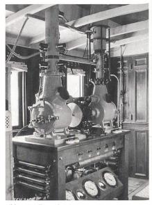
Bild 2 Oszillographen in Bergers Messwagen
