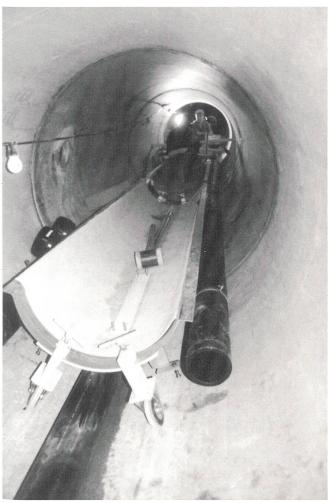
Bild 2 Elementweise werden die Wärmetauscher eingebracht und justiert; seitlich die Vor- und Rücklaufleitung (IBA Stadt Zürich).
