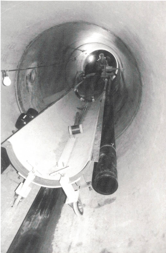
Bild 2 Elementweise werden die Wärmetauscher eingebracht und justiert; seitlich die Vor- und Rücklaufleitung (IBA Stadt Zürich).
