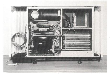
Bild 4 Blick ins Innere einer Heizkörper-Wärmepumpe: Links unten ist der Kompressor, rechts oben der Ventilator und darunter der Verdampfer zu erkennen.
