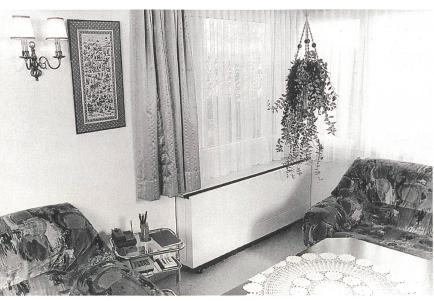
Bild 2 Heizkörper-Wärmepumpe (Bild Oerlikon Journalisten).
