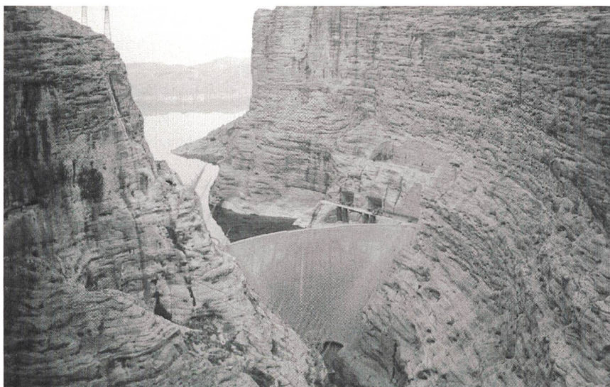
Bild 3 Bogenstaumauer Dez (max. Höhe 203,5 m) mit Wasserkraftzentrale am Fuss (520 MW)
