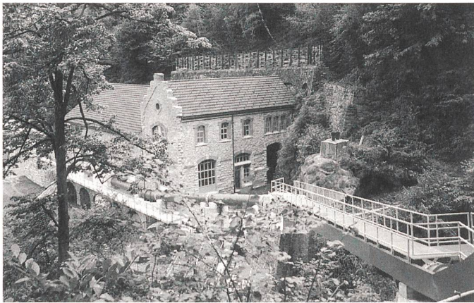
Die Fassaden des Gebäudes und die sich noch in gutem Zustand befindenden Innenteile des Kraftwerks Ticinetto sind erhalten und saniert worden. Die Gesamtkosten für die Erneuerung und Modernisierung beliefen sich auf etwa 8,6 Mio. Franken.
