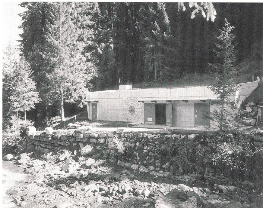
Die Zentrale Geissbrunnen im Saxettal: Das Trinkwasser aus den Quellen auf Alp Nessleren wird im Reservoir Stalden gesammelt und in einer 1. Stufe in der Zentrale turbiniert.
