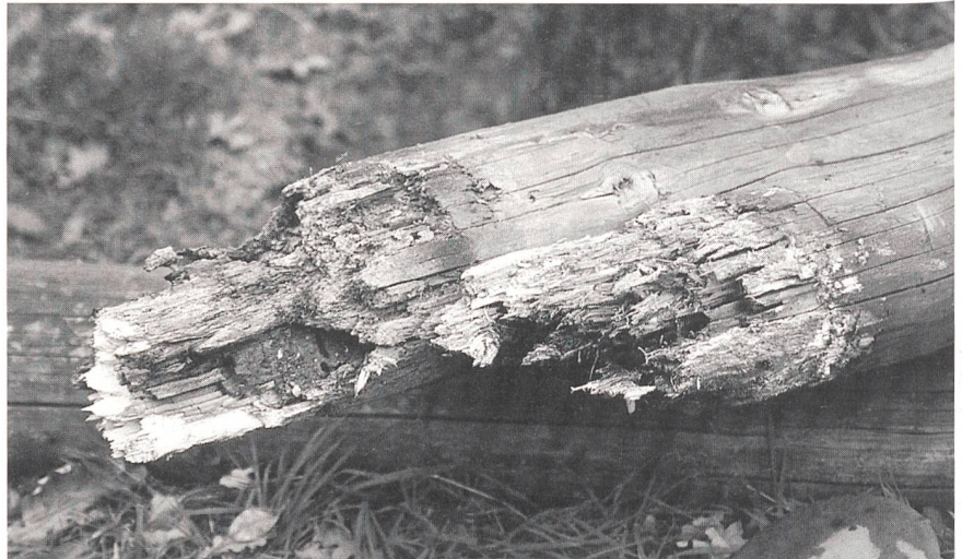
Moder- und Weissfäulepilze als Schadenursache.
