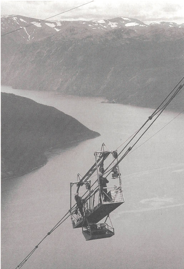
Bild 2 Montagearbeiten an Hochspannungsleitung über den Sognefjord.
