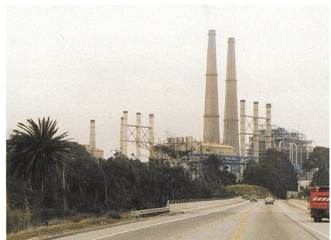
Bild 3 Gasturbinen-Kraftwerk mit angegliederter Prozesswärmenutzung südlich von San Francisco (Foto K. Niederau).
