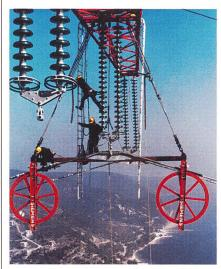
Titelbild: Zurzeit wird eine Hochspannungsleitung über den Bosporus gebaut, die ab Mitte 1999 den europäischen mit dem asiatischen Teil der Türkei verbinden soll (Übertragungsleistung 5600 MW; Länge 1880 m; Höhe 160 m (Bild Siemens).
