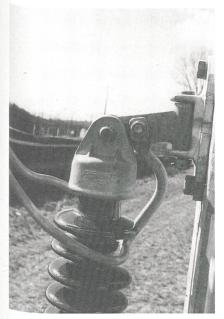
Fig. 9 Armature d'arc jouant le rôle d'amortisseur
