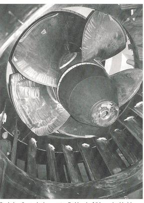
Dank dem Ersatz der imposanten Turbinenlaufräder und zahlreicher weiterer Sanierungsmassnahmen wird das Flusskraftwerk Wildegg-Brugg künftig mit einer installierten Leistung von 50 MW jährlich phase sind die umgebauten etwa 300 Mio. kWh Strom erzeugen können.
