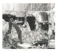
Der Abbruch des Maschinenhauses, der Betonspiralen und Saugrohre erfolgt mit Hydraulikbaggern mit Abbauhammer und Hydraulikschere.
