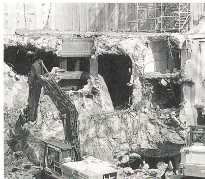
Der Abbruch des Maschinenhauses, der Betonspiralen und Saugrohre erfolgt mit Hydraulikbaggern mit Abbauhammer und Hydraulikscheren.
