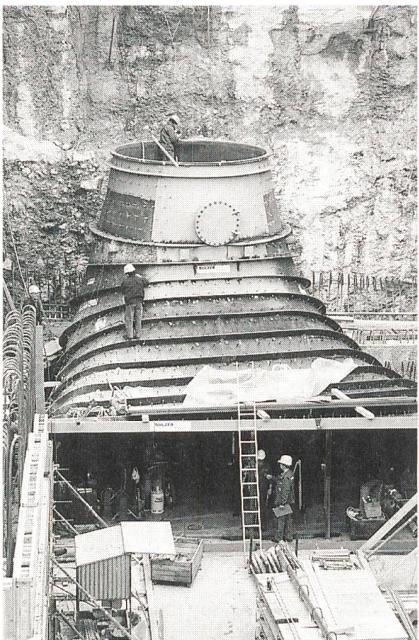
Montage der Saugrohrpanzerung für die neue Turbine 4.
